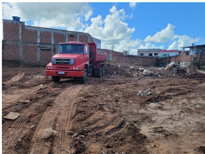
Foto 7: Transporte com caminhão, remoção dos entulhos demolidos.
