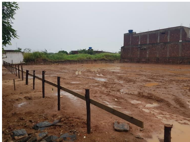
Foto 6: Locação da obra
