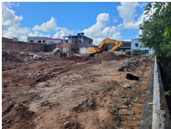
Foto 8: Escavadeira Hidráulica, demolição do prédio existente
